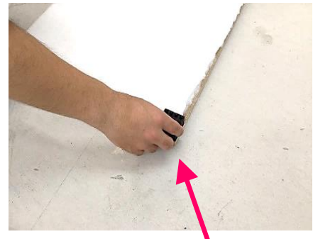
追加補充脚の貼り付け
