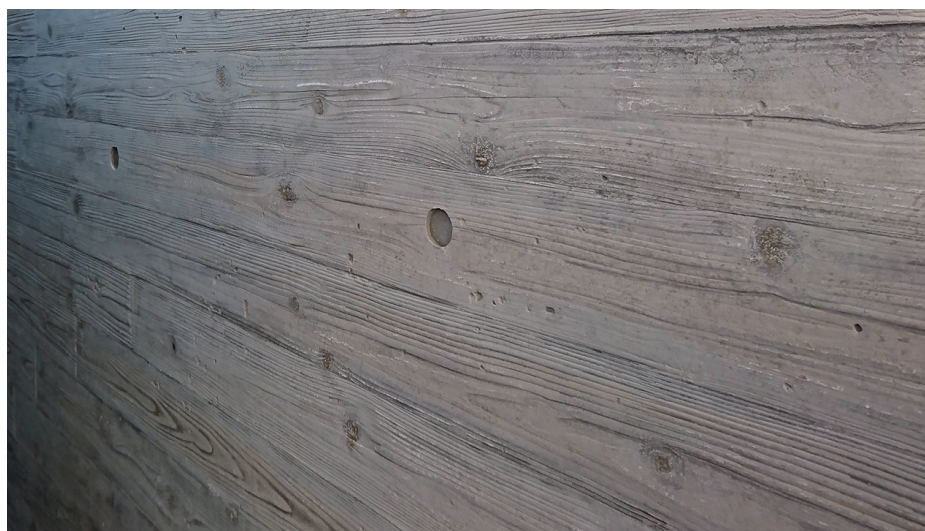
杉板の継目なく、長物で施工が可能。
